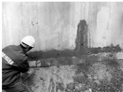
图6 埋管、封缝
