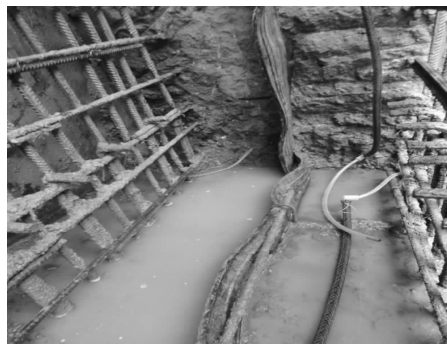
图1 止水带扭曲变形
