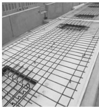
图3 凹槽内钢筋施工
