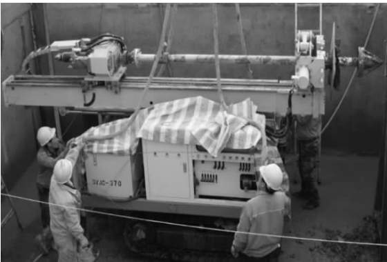
图2 采用小直径水泥土桩施工
