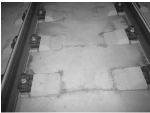
图 7 道床板裂纹
