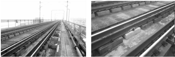
图 3 某客货共线铁路桥上无砟无枕式轨道
