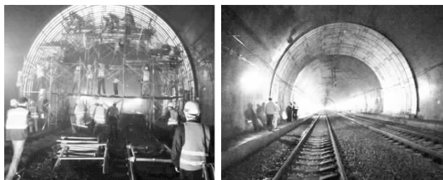
图8 波纹钢板施工及整治效果实景图
