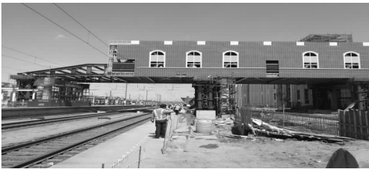
图4 第二次顶推现场实景图
