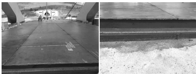
图11 梁面加固图
