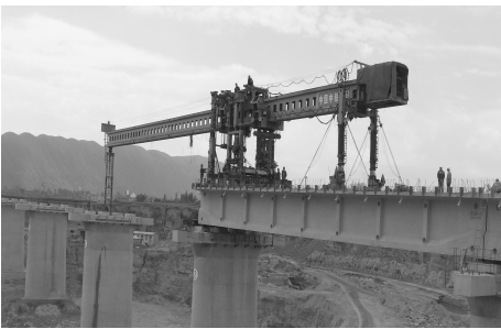
图2 DJ 180型架桥机架梁施工现场图
