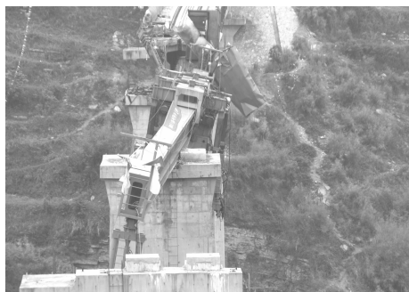
图 5 DJ 180 架桥机纵向失稳倾覆事故现场
