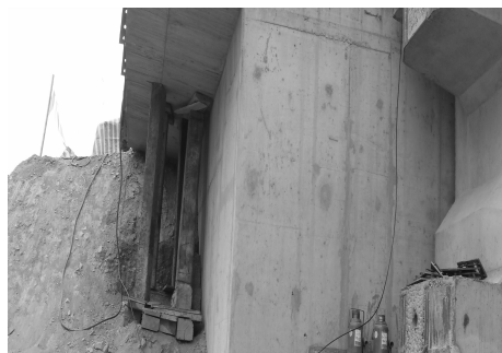
图8 首孔梁桥台顶板临时加固
