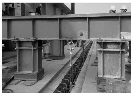
图 6 2 号柱横移轨道临时加固
