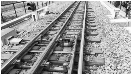
图1 新郑至马寨套轨铁路道岔转辙装置图
