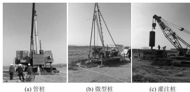
图 3 各桩型成桩工艺及施工设备图
