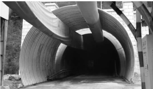
图 9 高强波纹板现场施工图
