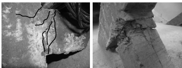
图8 椅式桩板结构裂缝发展图
