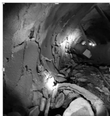
图1 跃龙门隧道3号斜井工区正洞变形图
