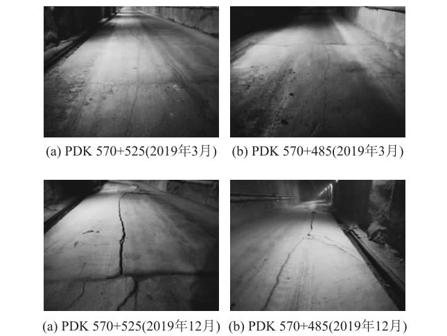
图4 2019年6月20日-2020年9月6日平导部分段落底板开裂上鼓图
