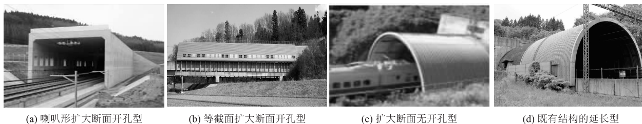
图1 缓冲结构的基本型式图
