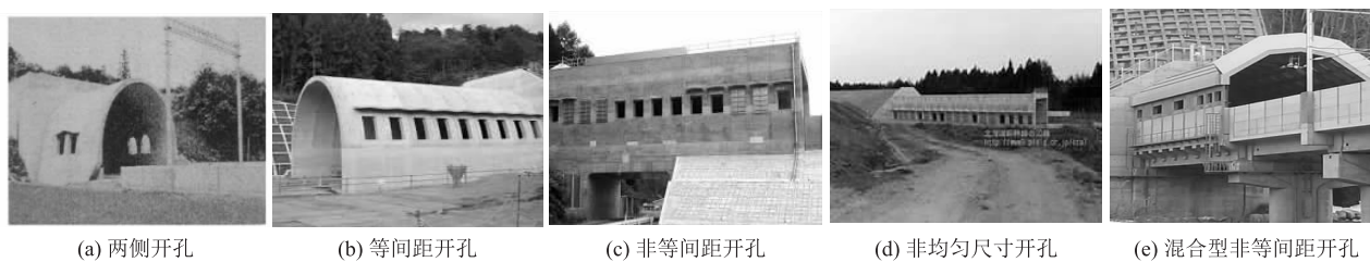
图2 缓冲结构的开孔型式图
