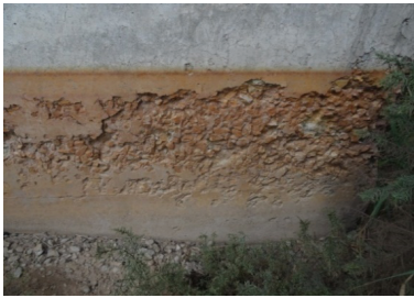
图 2 混凝土桥墩冻融破坏图
