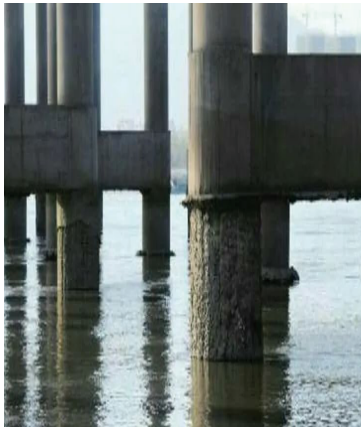
图 3 混凝土桥墩水沙冲蚀破坏图
