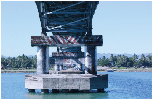
图 1 混凝土桥墩氯盐环境下侵蚀破坏图
