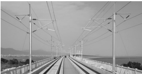
图 3 接触网正馈线“V”型悬挂安装示意图
